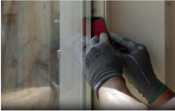
Sluit het draaideel nog niet goed? Plaats dan extra glasblokjes op de plek waar de meeste ruimte zit tussen het kozijn en het draaideel.
