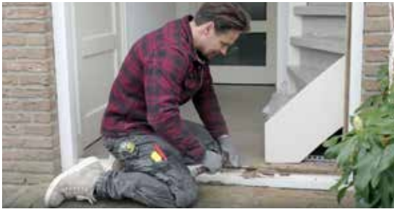
Verwijder alle overgebleven obstakels uit het houten buitenkader.
