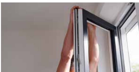
Laat het draaideel even schrikken door er wat gewicht op te plaatsen
