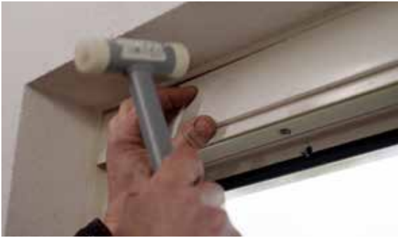
Tik de afwerkingstrips zachtjes vast op het kozijn met een zachte hamer.
