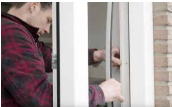
Verwijder de glaslatten in draaidelen
