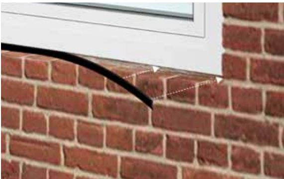
Wanneer er nog hout zichtbaar is aan de buitenzijde, dan dek je dit af met kunststof uitvulstrips.
