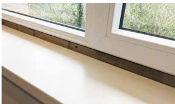
Bij smalle kozijnen vul je de ruimte tussen het ClickOver® kozijn en het houten kader uit met een uitvullat.
