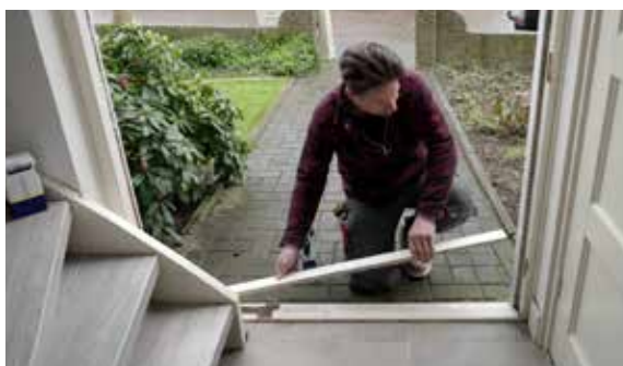
De houtensponning van de onderdorpel vul je uit met multiplex.
