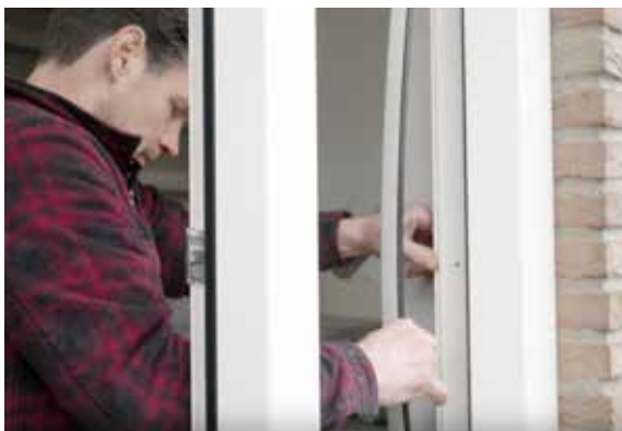
Verwijder de kunststof glaslatten van vast glas,
