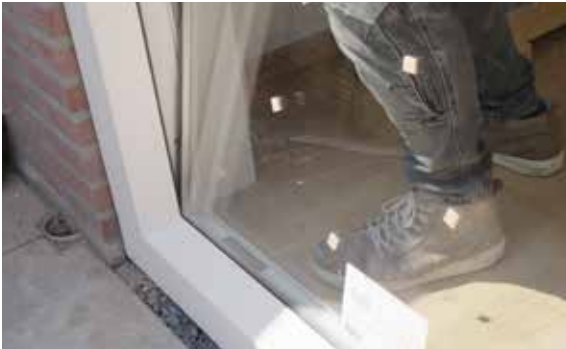
Plaats het glas op de onderste glasblokjes en kantel het vervolgens op zijn plek.
