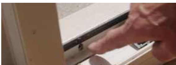
In de sponning van het kozijn zitten afwateringsgaatjes. Plaats een glasblokzadel nooit voor zo'n gaatje. Schuif in dat geval het glasblokzadel iets verder uit de hoek totdat het gaatje weer vrij is.
