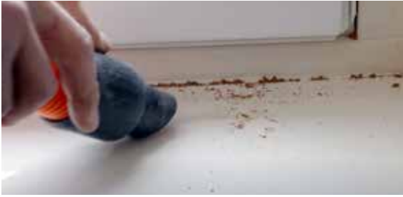
Verwijder al het stof en boorslijpsel met een stofzuiger of stoffer.
