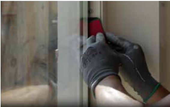
Vul de zijkanten nu uit met glasblokjes op de glasblokzadels.
