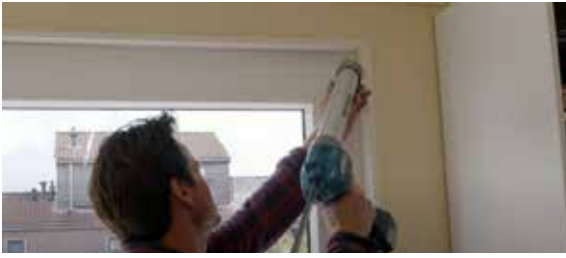
Kit de naadjes tussen de strips en je muur of aftrimmering netjes af.
