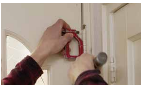
Met de scharnierpenlichter tik je oude scharnieren eenvoudig los
