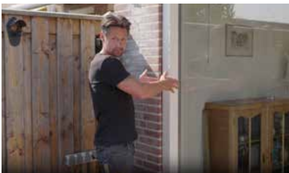
Glas en panelen in draaidelen werkt net iets anders dan het plaatsen van vast glas en panelen.
