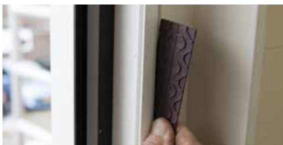
Met glasblokjes/uitvulplaatjes kun je het kozijn waterpas stellen.
