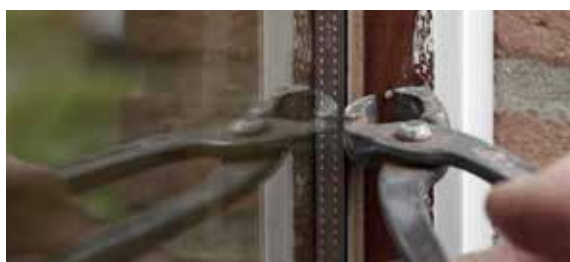
Verwijder alle obstakels voordat je het glas of paneel eruit tilt
