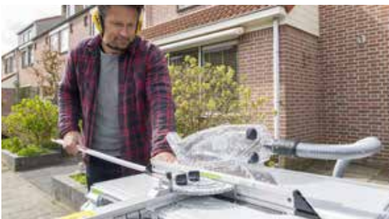
Zaag de afwerkingsstrips op maat
