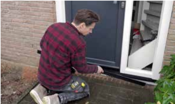
Werk de onderdorpel af met een zwarte kunststof hoekstrip.
