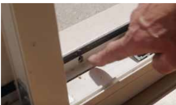
Via afwateringsgaatjes wordt overtollig vocht afgevoerd uit het kozijn, hou deze vrij.
