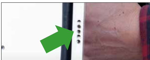
De onderzijde van het kozijn herken je aan de afwateringsgaatjes.
