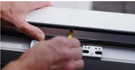
Prik ontwateringsgaatjes eenmaal per jaar door
