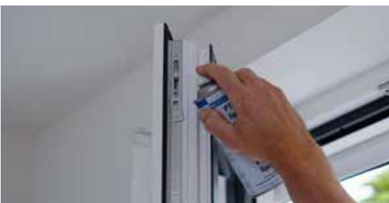
Smeer scharnieren met een teflon spray
