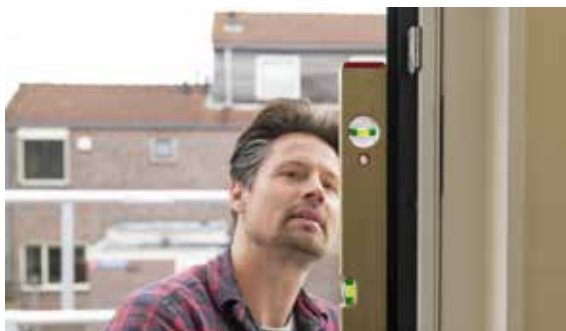
Controleer eerst of het kozijn waterpas staat
